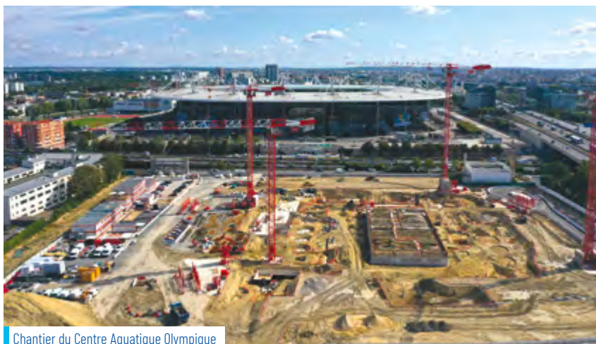
Chantier du Centre Aquatique Olympique à Saint-Denis en 2021.
