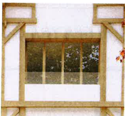
Menuiseries bois – enduit blanc Garde-corps vitrés
