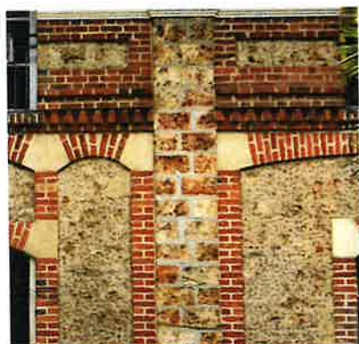
Moellons de pierre et brique.
