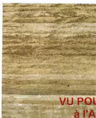
Béton de site
